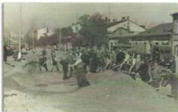
Rok 1956 – Pracownicy ZSP w czynie społecznym przy przebudowie ulicy Kunickiego
